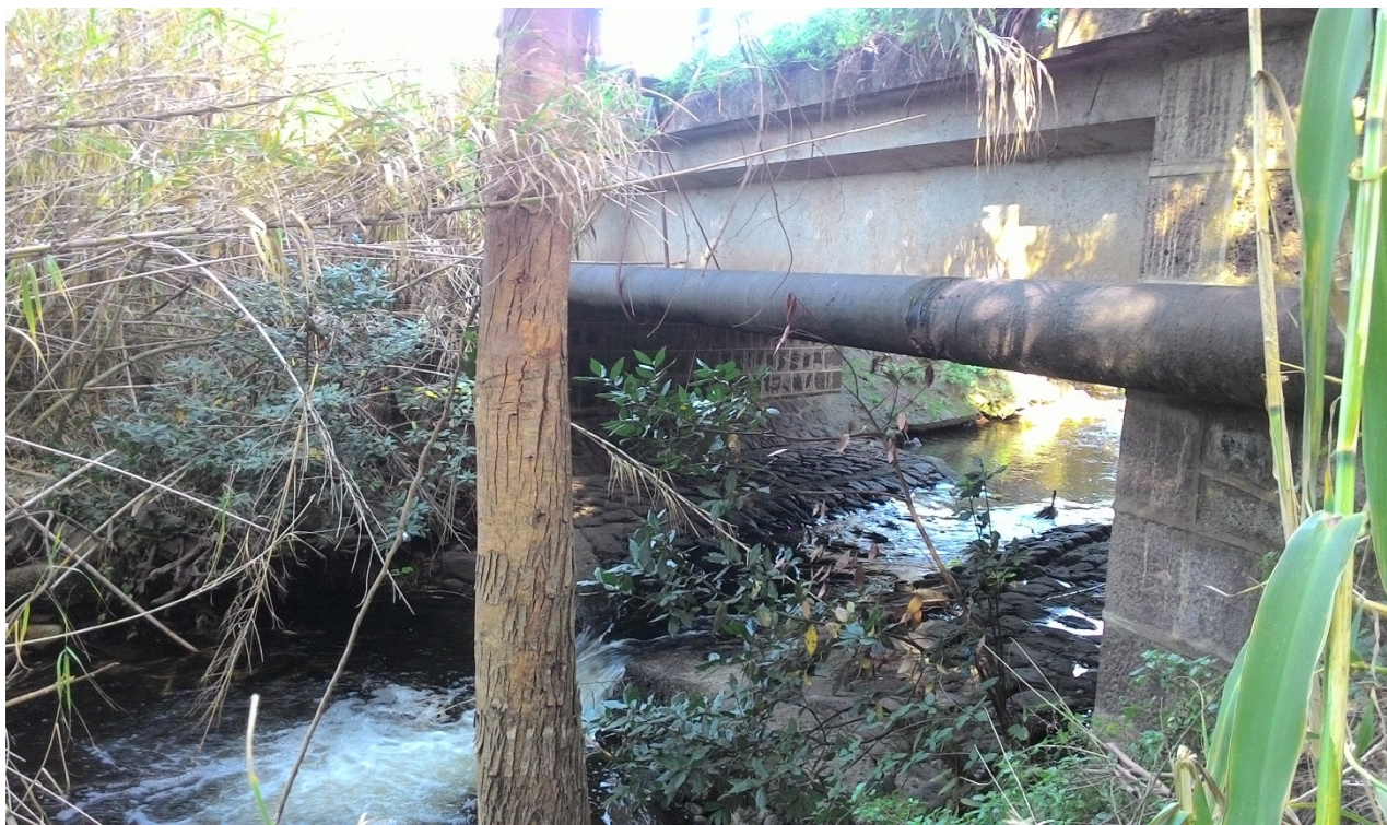
Foto n. 2 – Riu Mannu, particolare della soglia di fondo in corrispondenza dell'attraversamento della S.P. n. 17
